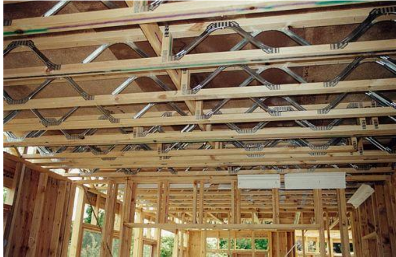
Fig. 19: Metal web joists (Mitek Posi-Joists)
