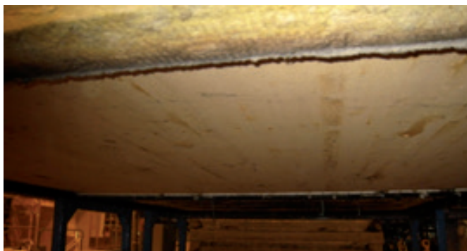
Oförstört underlag (spånskiva) bakom träbeklädnad efter brandprov
