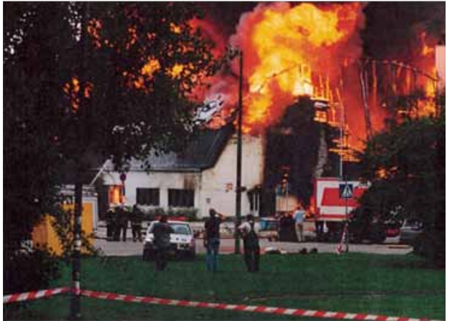
Totalskada under ombyggnad p g a svetsarbete.
