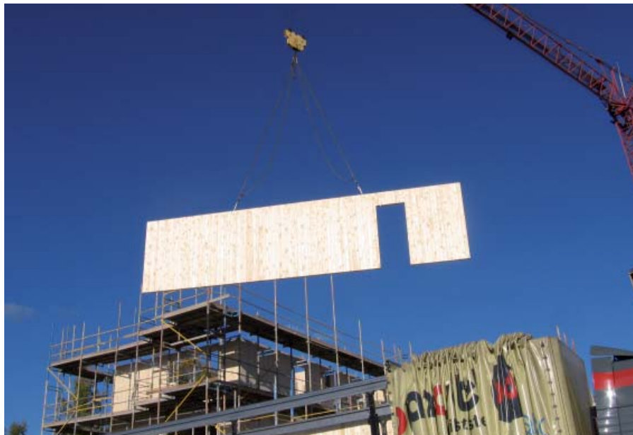
Väggelement på väg i Hyttkammaren i Falun.
