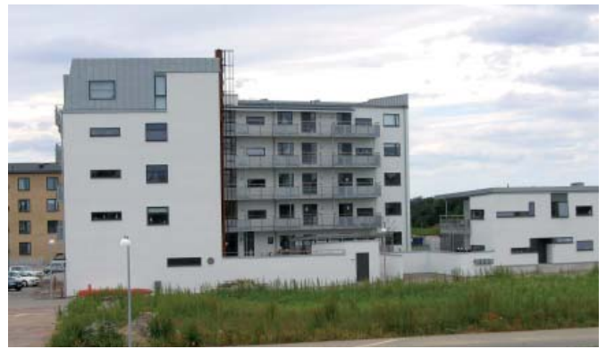
Rydebäck i Helsingborg är ett bostadshus i fem våningar.
