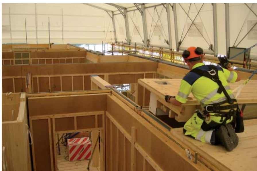
Montage av bjälklag i Limnologen i Växjö.
