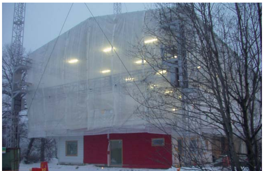
Väderskydd med montageplattform i Älvsbacka strand i Skellefteå.
