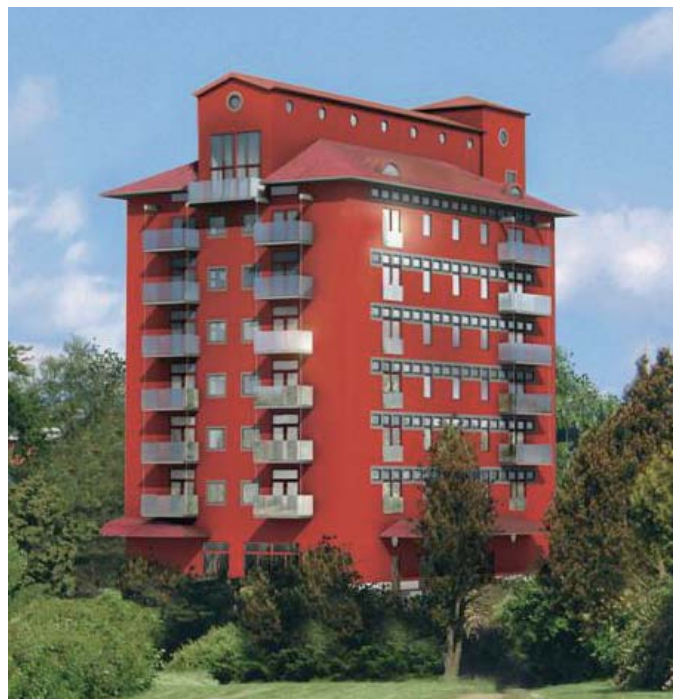
Ein zum Mehrfamilienhaus umgebauter ehemaliger Getreidespeicher, Eslöv, Schweden.
