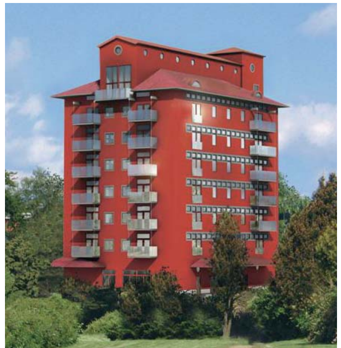
Casa plurifamiliare, ex deposito di mais, Eslöv, Svezia.
