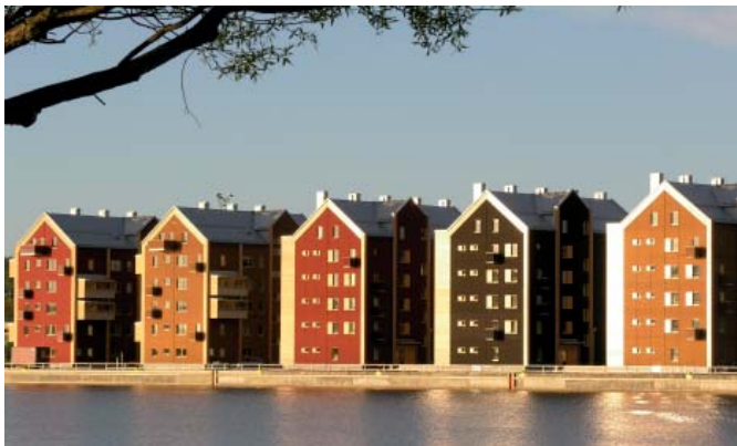
Case multifamiliari, Porto interno, Sundsvall, Svezia.
