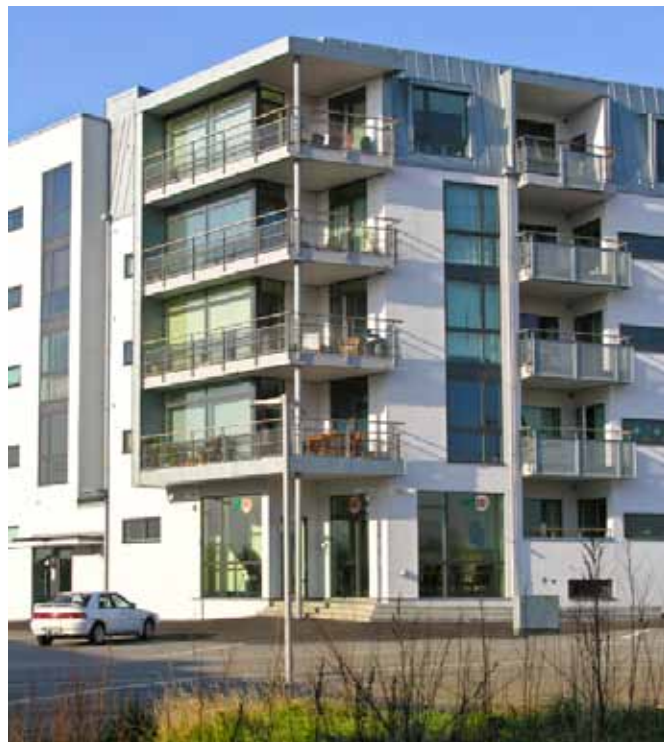
Multifunkčný dom, Rydebäck, Helsingborg, Švédsko.
