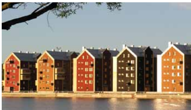
Multifunkčný dom, Inner harbour, Sundsvall, Švédsko.
