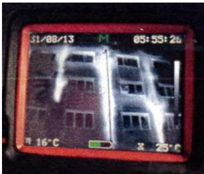
Figur 1. Brandspridning neråt i modulskarvar, bild med IR kamera /3/.
