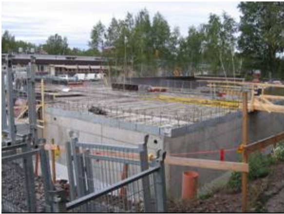
Bild 1. Grunden gjuten.
