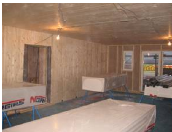
Bild 10. Stomme före montage av gips
