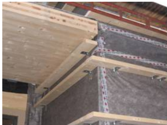
Bild 6. Infästning av bjälklag
