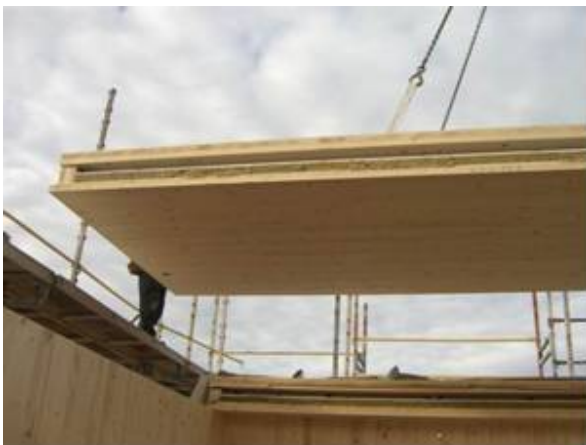
Bild 5. Bjälklag på väg
