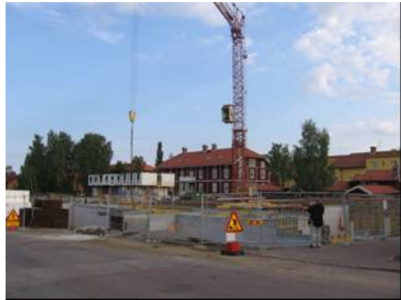
Bild 2. Trämонтаget har börjat.
