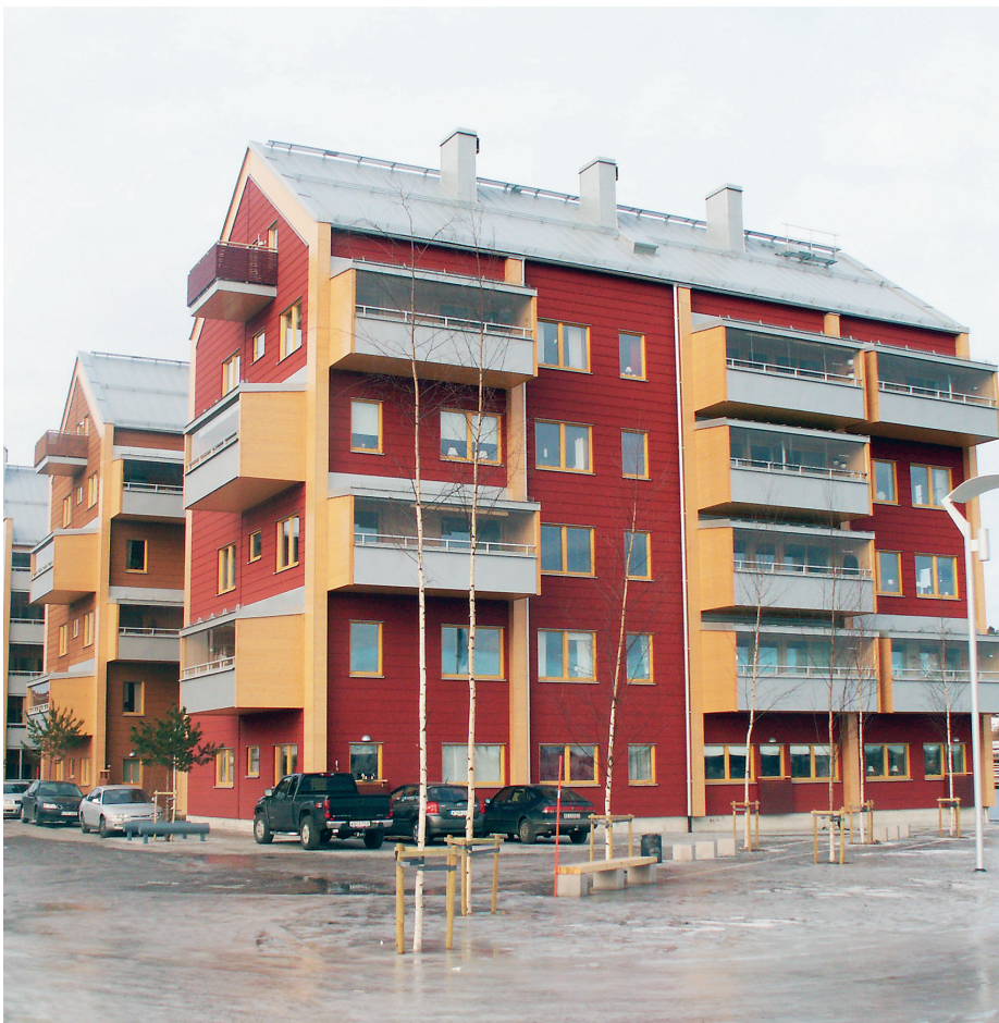
Träfasad i flera våningar är ett exempel på tekniskt byte. Bilden visar sexvånings trähus i Sundsvalls inre hamn.
