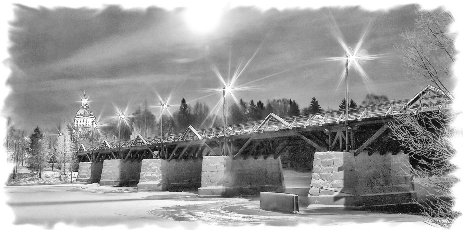
The Lejonström bridge Skellefteå
