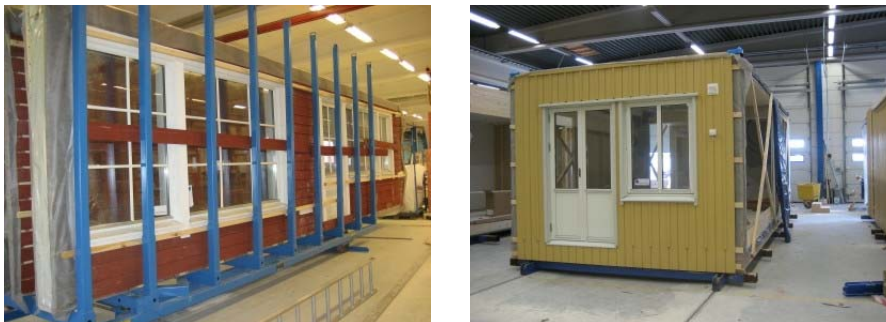
FIGUR 10. OLIKA TYPER AV ELEMENT. TILL VÄNSTER PLANELEMENT, TILL HÖGER VOLYMELEMENT (STUDIEBESÖK "TRÅHUS" 2007)
