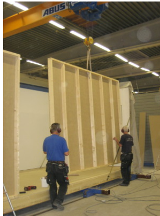
FIGUR 37. MONTERING PÅ VOLYMELEMENTLINAN AV EN INNEVÄGG (STUDIEBESÖK ”TRÄHUS” 2007)
