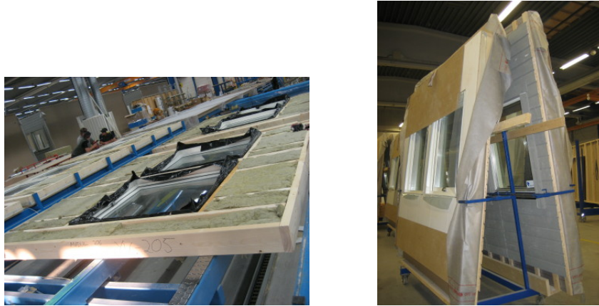
FIGUR 35. TILL VÄNSTER YTTERVÄGGSLINAN OCH TILL HÖGER FÄRDIGA YTTERVÄGGAR (STUDIEBESÖK "TRÄHUS" 2007)
