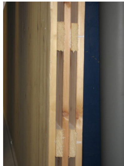
FIGUR 3. VÄGGKONSTRUKTION I LÄTTVIKTSTRÄ TILL VÄNSTER, VÄGGKONSTRUKTION I MASSIVTRÄ TILL HÖGER (STUDIEBESÖK "TRÄHUS" 2007)
