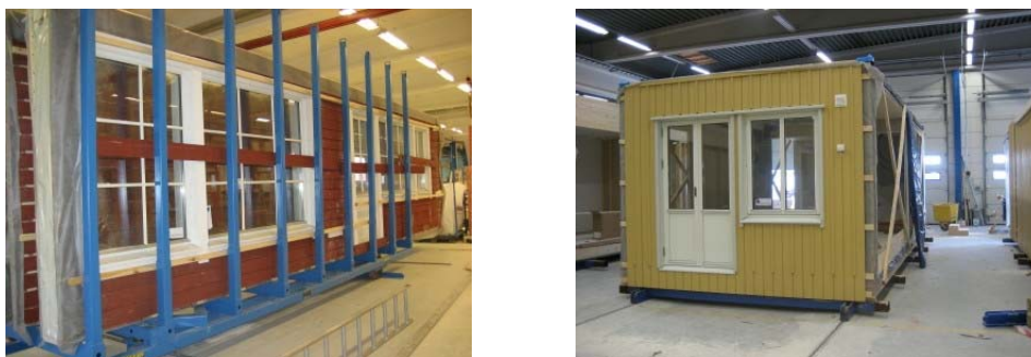
FIGUR 2. OLIKA TYPER AV ELEMENT. TILL VÄNSTER PLANELEMENT, TILL HÖGER VOLYMELEMENT (STUDIEBESÖK "TRÄHUS" 2007)
