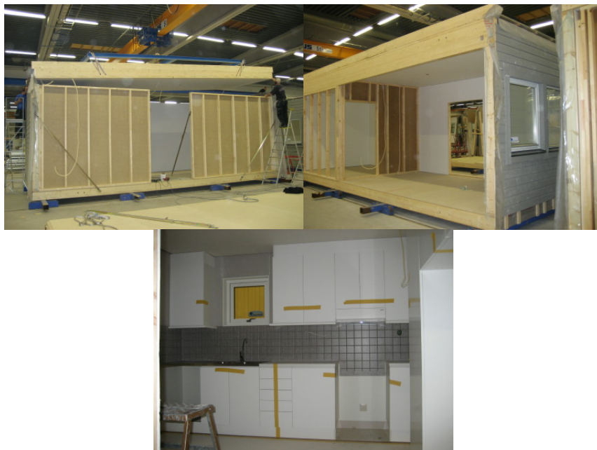
FIGUR 39. VOLYMELEMENT, MONTAGE AV TAK, INSYN I EN MODUL SAMT ETT INSATT KÖK (STUDIEBESÖK "TRÄHUS" 2007)
