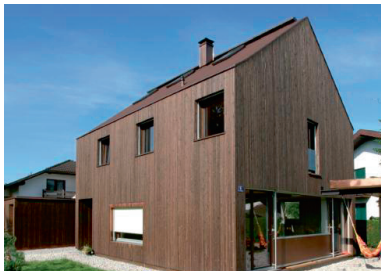
Figur 5.25 Fasad med brunlaserad panel. Arkitekt: Lang & Vonier arkitekten
