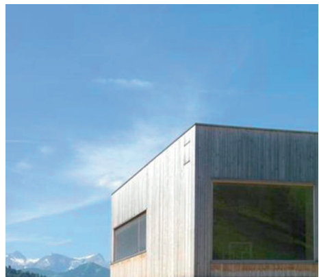
Figur 5.34 Samma hus som ovan där man kan se en begynnande gråningsprocess på träfasaden. Mot plåtblecket som delar fasaden syns den kraftigaste mörkfärgningen. Bild från www.archdaily.com
