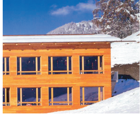
Figur 5.32 Skolbyggnad med massiva ytterväggar av trä. Den obehandlade fasaden som består av liggande plank har här kvar sin varmgula träton. På sikt grånar fasaden. Bild från www.archdaily.com
