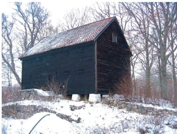
Figur 5.22 Timmerfasad som fått en svartbruna färg med hjälp av stenkolsstjära. Magasinsbyggnad, Småland. Foto: Författaren
