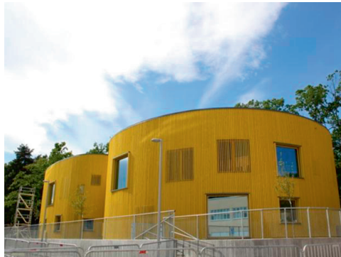
Figur 6.4 Dagheimsbyggnad i organisk form med träfasad med vertikala träreglor som bitvis bildar raster. Videgård & Hanson arkitekter
