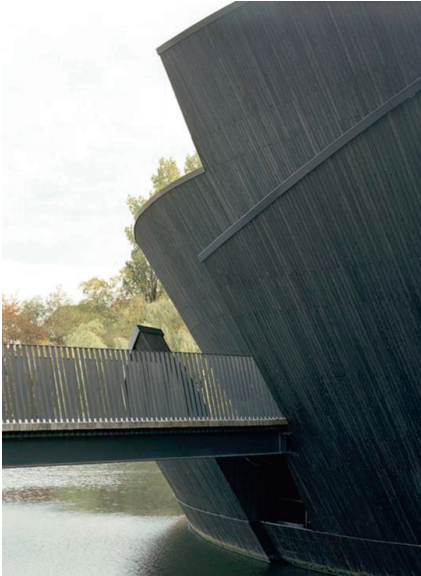
Figur 5.7 Fasad med bränd panel som skapar en förkolnad yta som skyddar träet. En gammal träskyddsmetod som här använts på ett nyskapande sätt. Muritzeum museum, Tyskland. Wingårdhs arkitektkontor. Foto: Åke E:son Lindman
