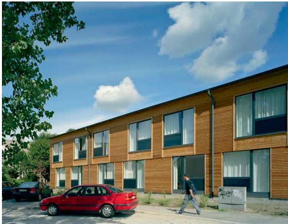
Figur 5.53 Studentbostadshus med prefabricerade stomelement. Fasaden av lärkträ som är platsbyggd antyder ändå en prefabriceringsestetik. Moduliserade fasadfält med två olika paneltyper och förskjutningar skapar rytmik i fasaden. Kjellander och Sjöberg arkitekter 2002. Foto: Åke E:son Lindman
