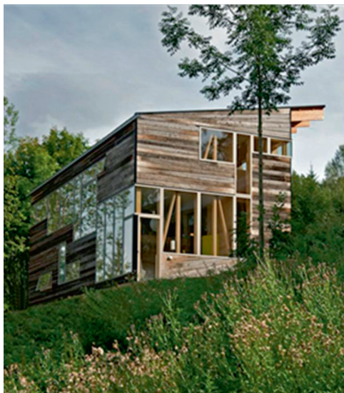
Figur 5.31 Farm House. Norge, där panelen utgörs av återanvänd träpanel från en tidigare uthusbyggnad på platsen. Arkitekt: Jarmund/Vignsnaes AS. Bild från www.jva.no
