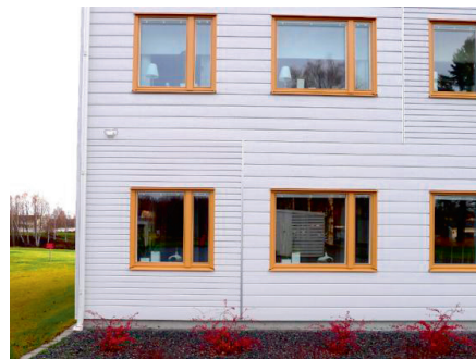
Figur 5.26 Flerbostadshus med fasad målad i vit täcklasyr. White arkitekter. Foto: Författaren
