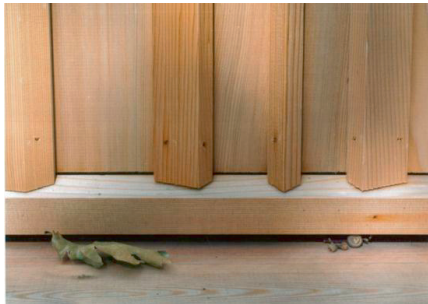
Figur 6.7 Varierande dimensioner och listformer i ett system som på ett enkelt sätt skapar rytm i en lärkträfasad. Hög precision i detaljutförandet. Arkitekt Camilla Schlyter. Foto: Luc Pages.
