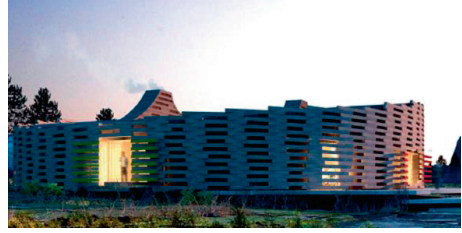
Figur 6.6 Arkitektur med fokus på ny teknik, ekologi, trä och byggande i arkitekiskt klimat. Ytervägg och fasad av massiv liggande träbjälkar. Arkitektävlingförslag Wingårdhs.
