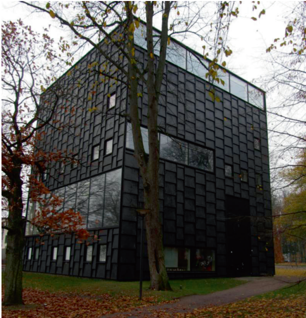
Figur 5.5 Kalmar konsthall 2008. Fasad uppbyggd med plywoodskivor och träreglar till en slags storskalig fjällpanel. Byggnaden utfördes med träfasad, trots skepsis vad gällde underhållsfrågor från juryn i den arkitekttävling som föregick projektet. Tham & Videgård arkitekter. Foto: Henrik Karlsson
