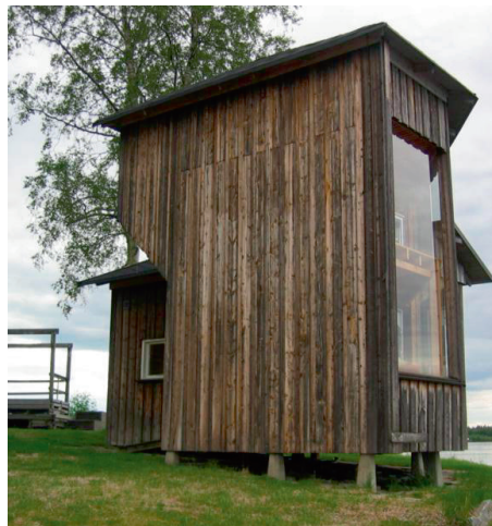
Figur 5.29 Obehandlad träpanel som skiftar i olika färgtoner från ljusbrunt till svartgrått. Foto: Författaren
