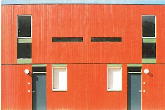
Figur 5.52 Prefabricerat byggsystem med fasadmoduler med släta paneler, integrerade fönster utan foder och lister. Arkitekt Roland Schweitzer 1970, som i sina arbeten tagit intryck av gammal japansk träarkitektur. Foto ur Construire en bois 2
