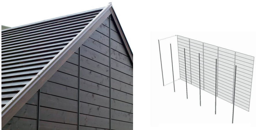
Figur 5.54 Utställningsbyggnad i värmebehandlat trä med stomme av prefabricerade limträelement. Fasaden av värmebehandlad gran utgörs av ett fasadsystem med ställister som klämmer fast de liggande panelerna varför de inte behöver skruvas eller pikas. Nilsson & Sahlin arkitekter 2007. Foto: Författaren
