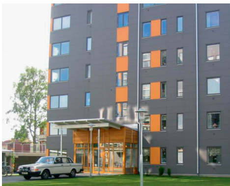
Figur 5.3 Flerbostadshus med fasadskivor i fibercement. Entrén har fått en exklusiv beklädnad med ekpanel som klarlackats.
