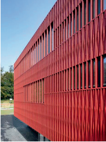
Figur 6.1 Fasad med flätade träribbor. Skola Luzern, Schweiz Arkitekt: Rohrer Sigrist Architekten . Bild från www.rohrer-sigrist.ch
