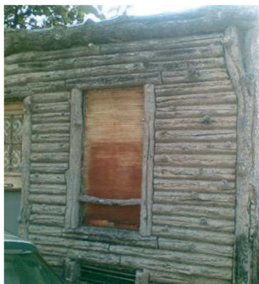
Husfasad i Nice. Trä i betongutförande.
