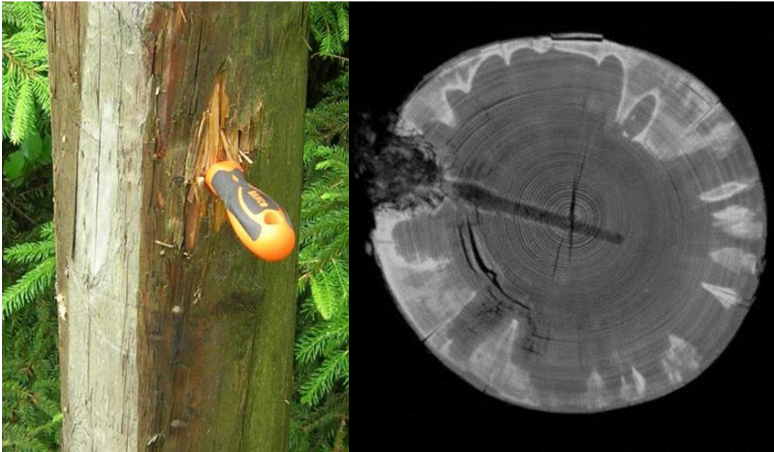
Figur 28. Röta i stolpe till vänster och tomograferingstvärsnitt till höger. Inträngningen av skruvmejseln kan ses i bilden.
