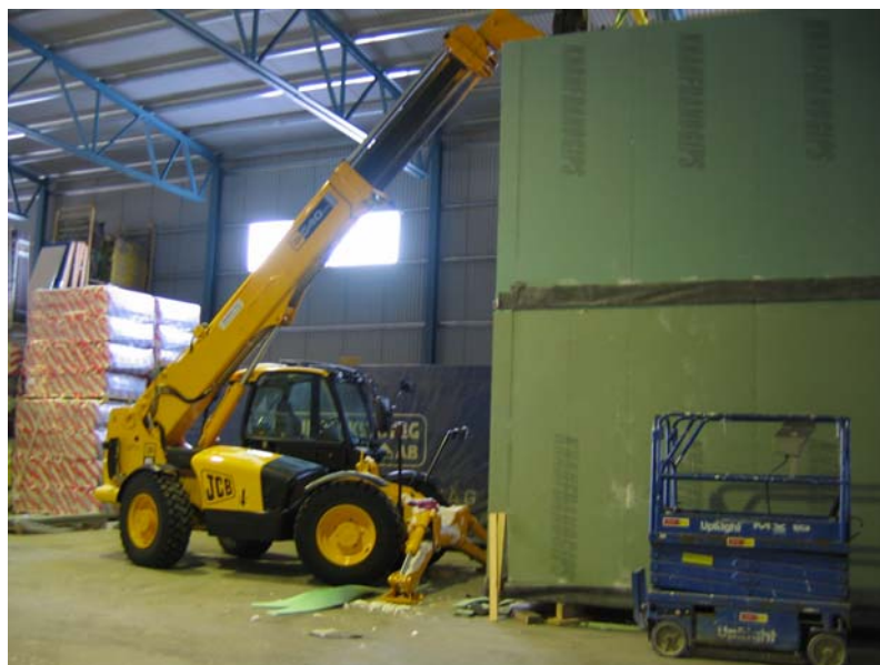
Figur 4. Övre planets modul lyfts upp med två traktorer som är placerade i vardera kortände med lyftpunkt någon meter in från respektive kant.
