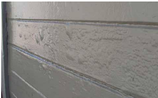
Figur 4. Exempel på blåsbildning Mängd 5, Tätt mönster av blåsor, Storlek 5, Blåsornas storlek är större än 5 mm
