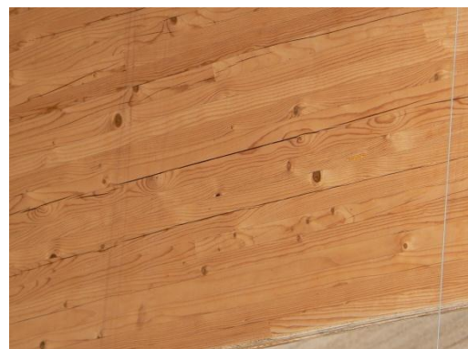
Sprickor i takbalk, Foto: SP Trä
