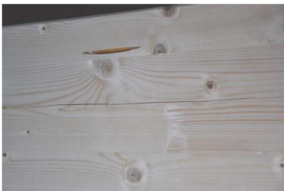
Takbalk med spricka. Foto: Setra
