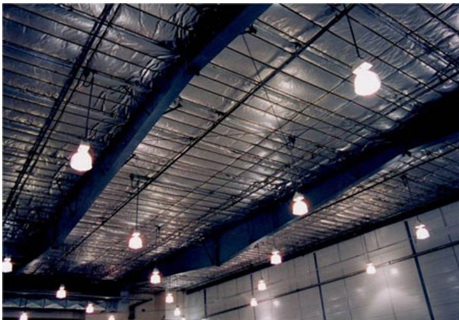
Figur 2. Låg emissionsförmåga barriären (folie) som används för att minska värmeförlusterna från isbana tak
