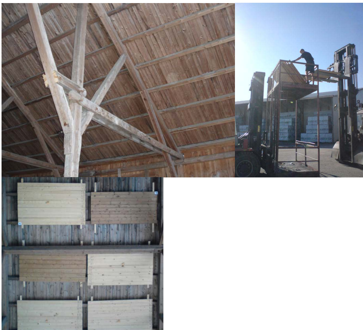
Figur 5 Bilder från montering av provpanelerna mot innertaket i ett virkesmagasin.
