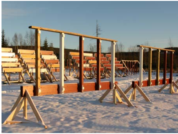
Räcketstolpar monterade.
